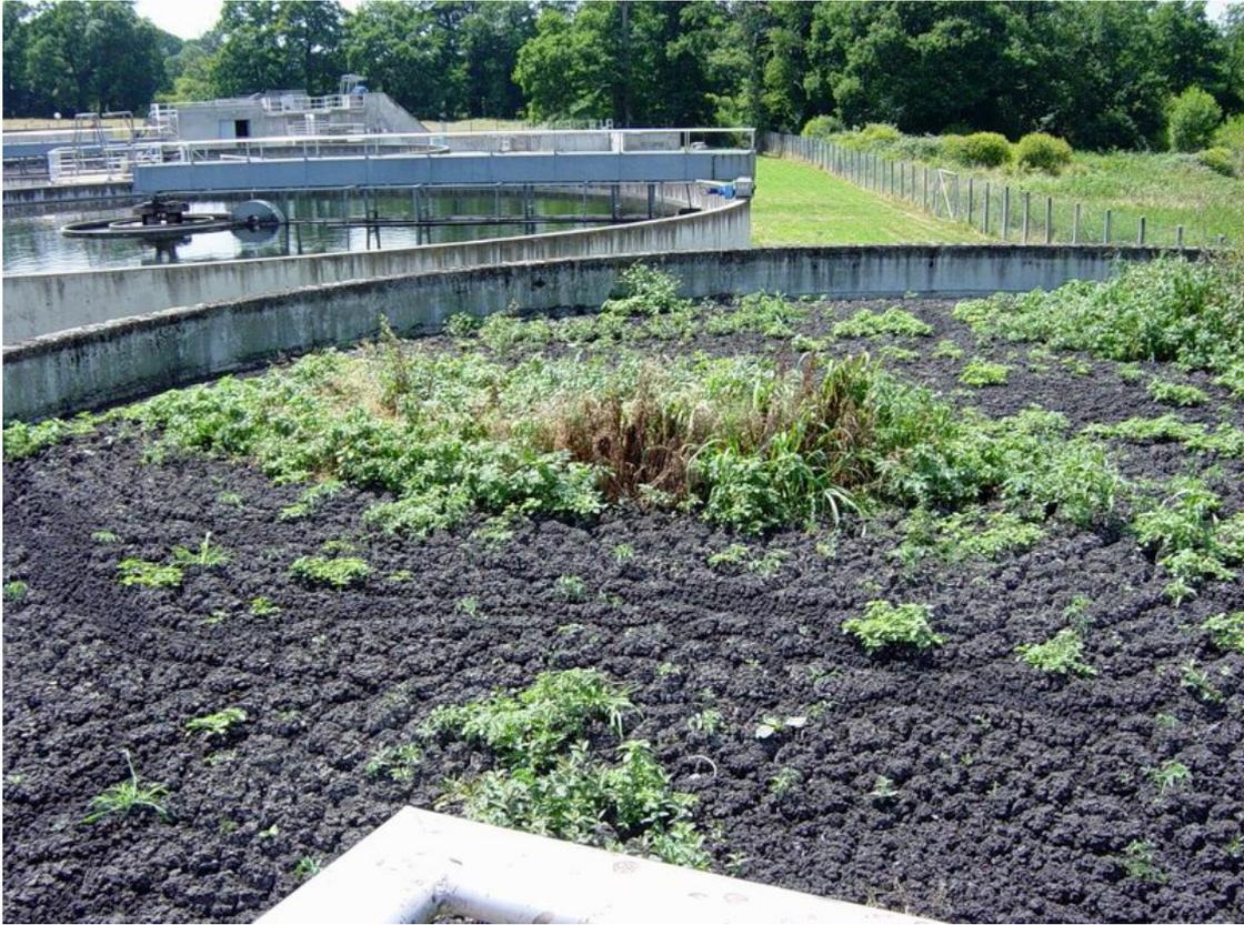
**Photo 6 : Silo à boues sans agitateur de la station d'épuration de Guéret**
